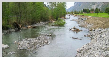
Aufweitung des Berschnerbach mit Strukturelementen und variablen Breiten (Bauzustand).
